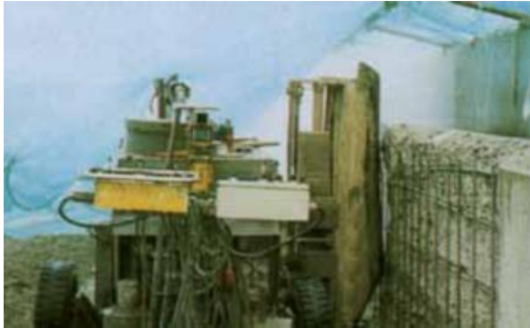
Figuur 35: Waterstraalrobot die brugwand aanpakt (HSE, 1997)
