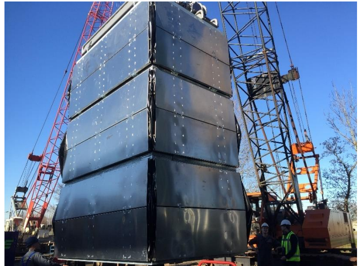
Figuur 28: Harmonicavormige mantels rond de paal (website Vroom Funderingstechnieken en website Dieseko Group)
